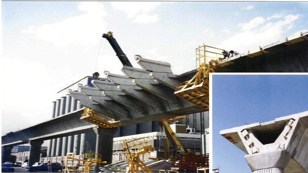
Montaje de cartelas ( arriba ), sección tipo de pila-dovela-parapeto ( recuadro ) y estación Cuauhtémoc ( abajo )
