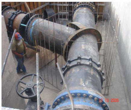
Obra de Toma (arriba)
